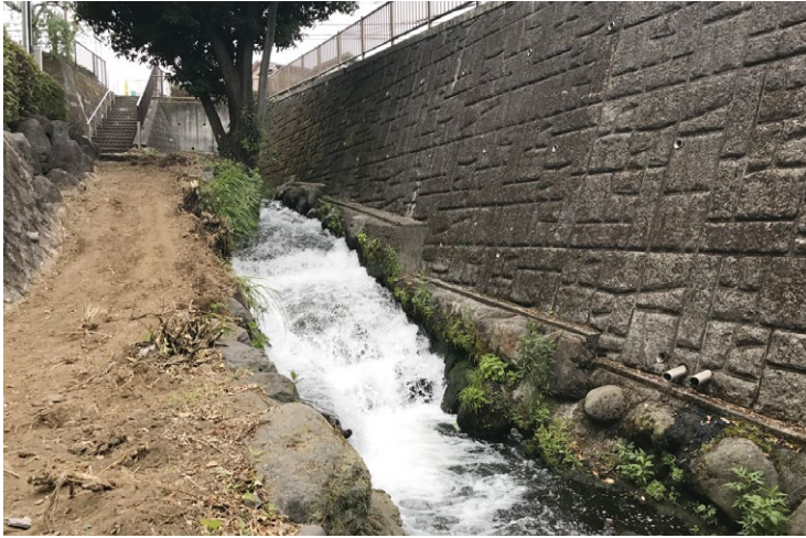
タービン式の小水力発電設備設置予定地 (福祉会館南側黄瀬川へ放流する水路)
