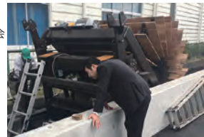
町内桜堤付近に設置された水車型小水力発電
