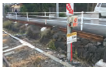
近隣住民より、ガードレール老朽化の相談を受け要望活動。新設されたガードレール。
