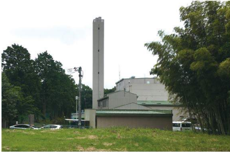
東野にある塵芥焼却場
